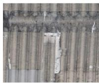
Extractores de grasa que no tienen ni la trampa ni un adecuado sistema de filtrado. Se aprecian manchas de grasa en el techo que podrían provocar incendio.
